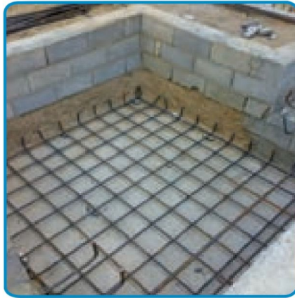
شکل ۷-۲- اجرای میلگردهای طولی و عرضی کف پی
