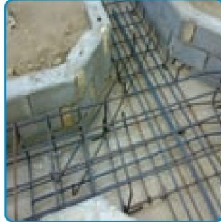
شکل ۷-۱۳- قرار دادن میلگردهای تقویتی پخ‌ها
