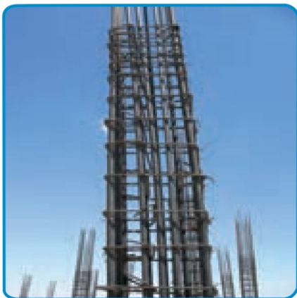
شکل ۱۹-۷- کار گذاشتن میلگردهای انتظار ستون، در فونداسیون
