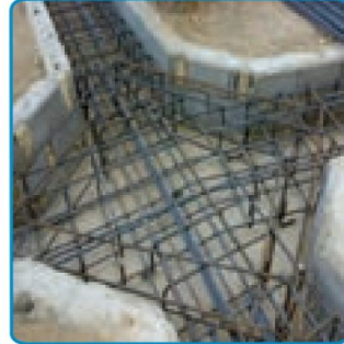
شکل ۷-۱۴- تکمیل میلگردگذاری محل اتصال ستون
