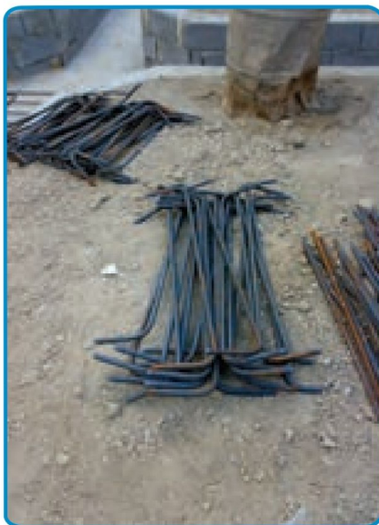
شکل ۷-۷- آماده کردن میلگردهای طولی و عرضی
