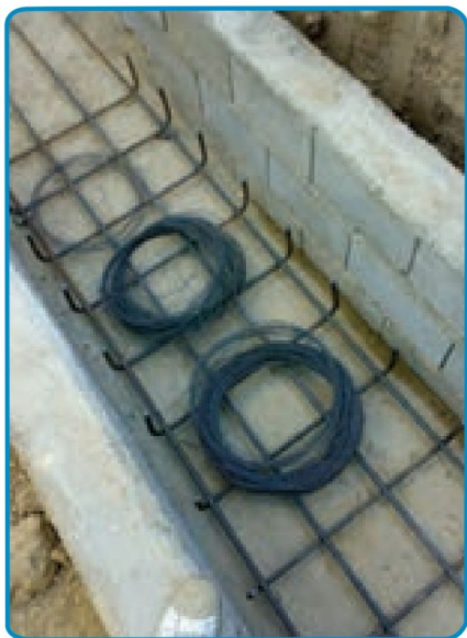
شکل ۷-۹- به هم بستن میلگردها
