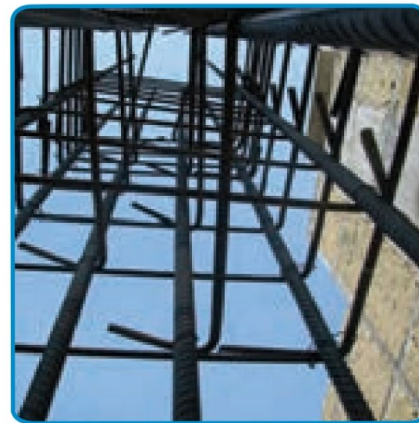
شکل ۱۹-۷- کار گذاشتن میلگردهای انتظار ستون، در فونداسیون
