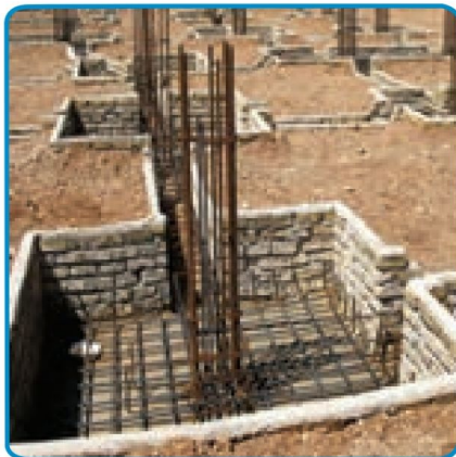
شکل ۷-۴- اجرای میلگردهای ریشه انتظار
