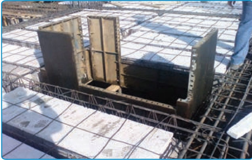
شکل ۳۵-۷- تکمیل قالب‌بندی
