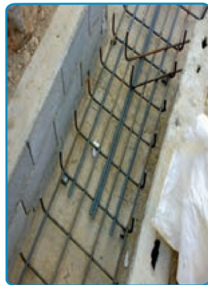
شکل ۷-۱۱- قرار دادن میلگردهای تقویتی
