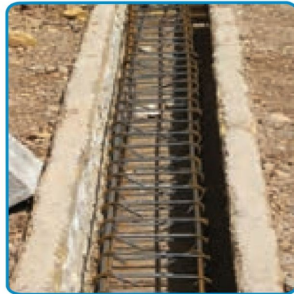
شکل ۷-۵- اجرای میلگرد شناژها
