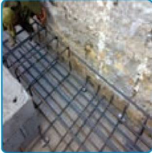
شکل ۷-۱۲- میلگردگذاری شبکه‌بالیایی
